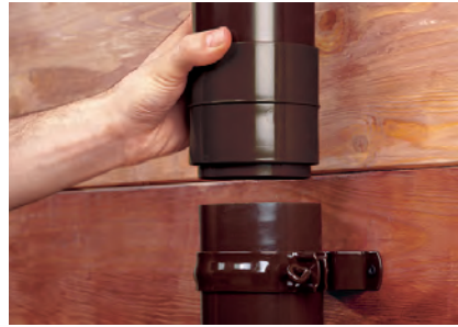
Collegamento delle tubazioni
