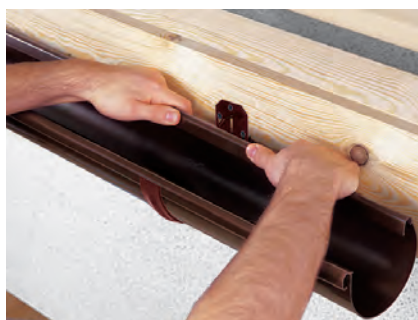
Installazione della grondaia nella staffatura d'acciaio
