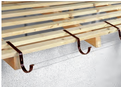
Installazione della cicogna superiore
