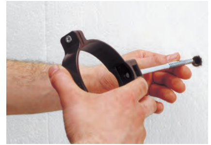
Fissaggio dei discendenti a una parete cementizia
