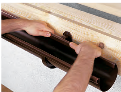
Installazione della grondaia nella staffatura in plastica
