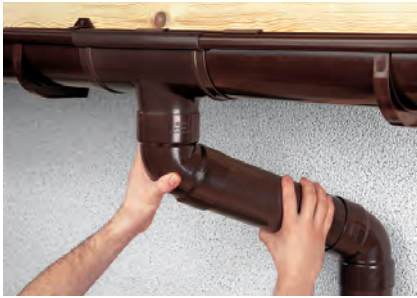
Installazione dei discendenti mediante due curve e un tratto di tubazione.
