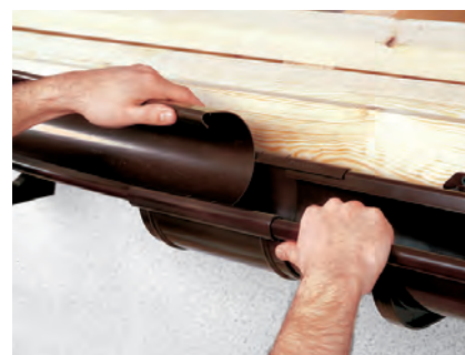
Installazione del giunto
